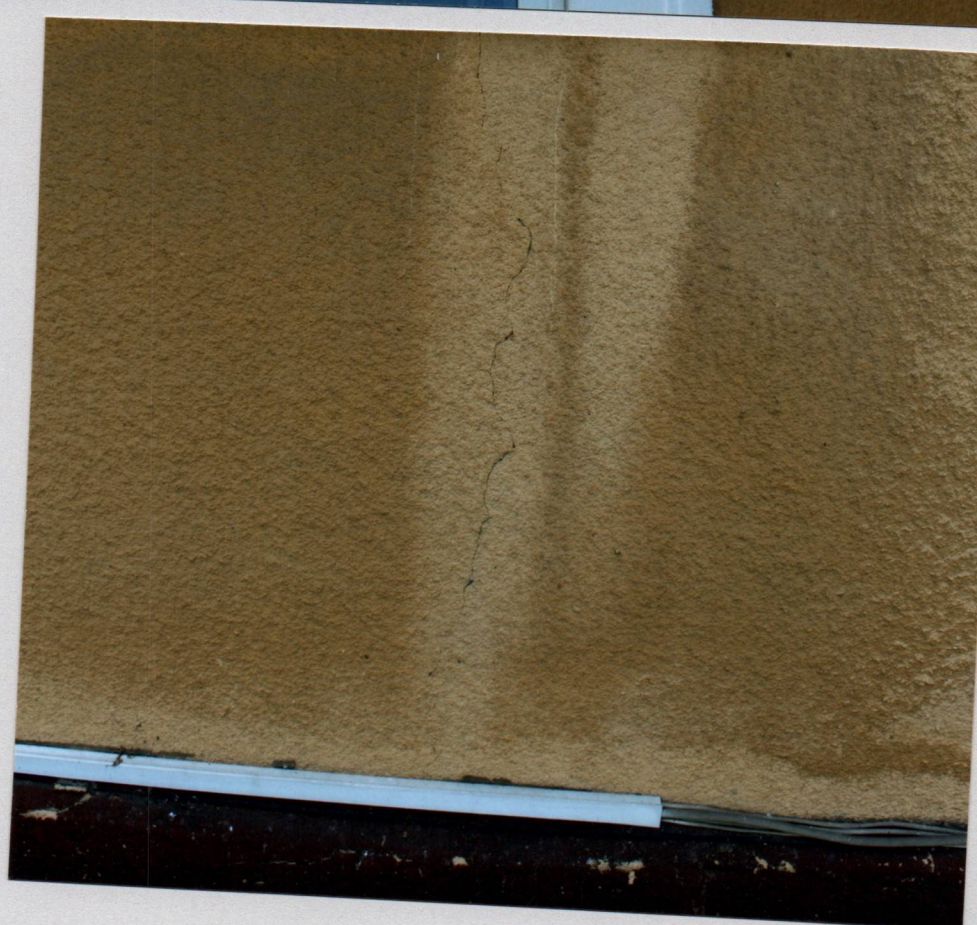
Fot. 7 – Rudółtowice, pałac Zborowskich. Widok na fasadę pałacu od strony północno – wschodniej. Stan zachowania dekoracji okna (spękania rozległe i szerokie w zwieńczeniu okna) oraz spękania i odbarwienia współczesnych tynków na elewacji.
