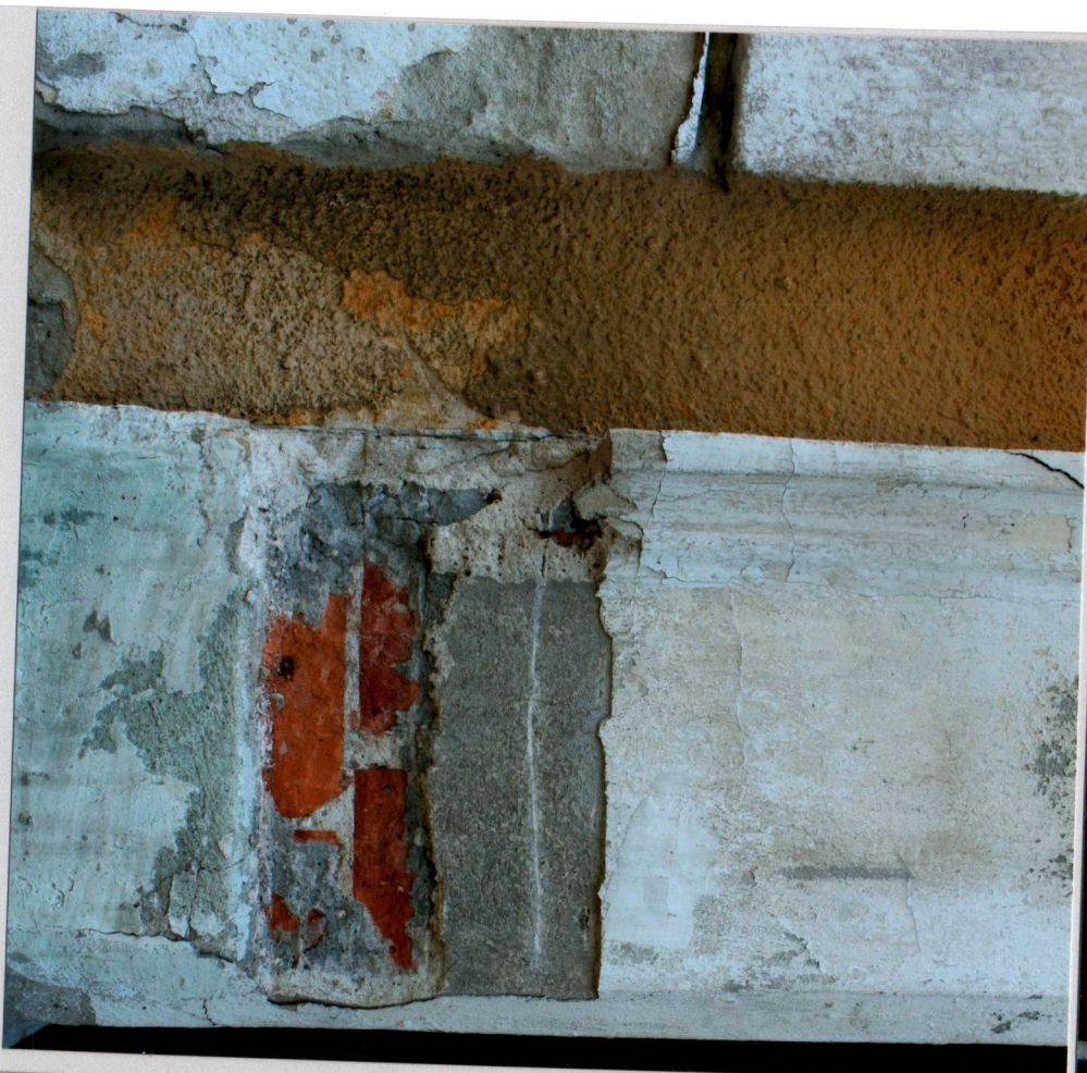
Fot. 43 – Rudółtowice, pałac Zborowskich. Elewacja od strony północno – zachodniej. Odkrywka nr 1. Widoczne uszkodzenia struktury muru i tynków spowodowane montażem współczesnych instalacji z zastosowaniem m.in. silnych zapraw cementowych.
