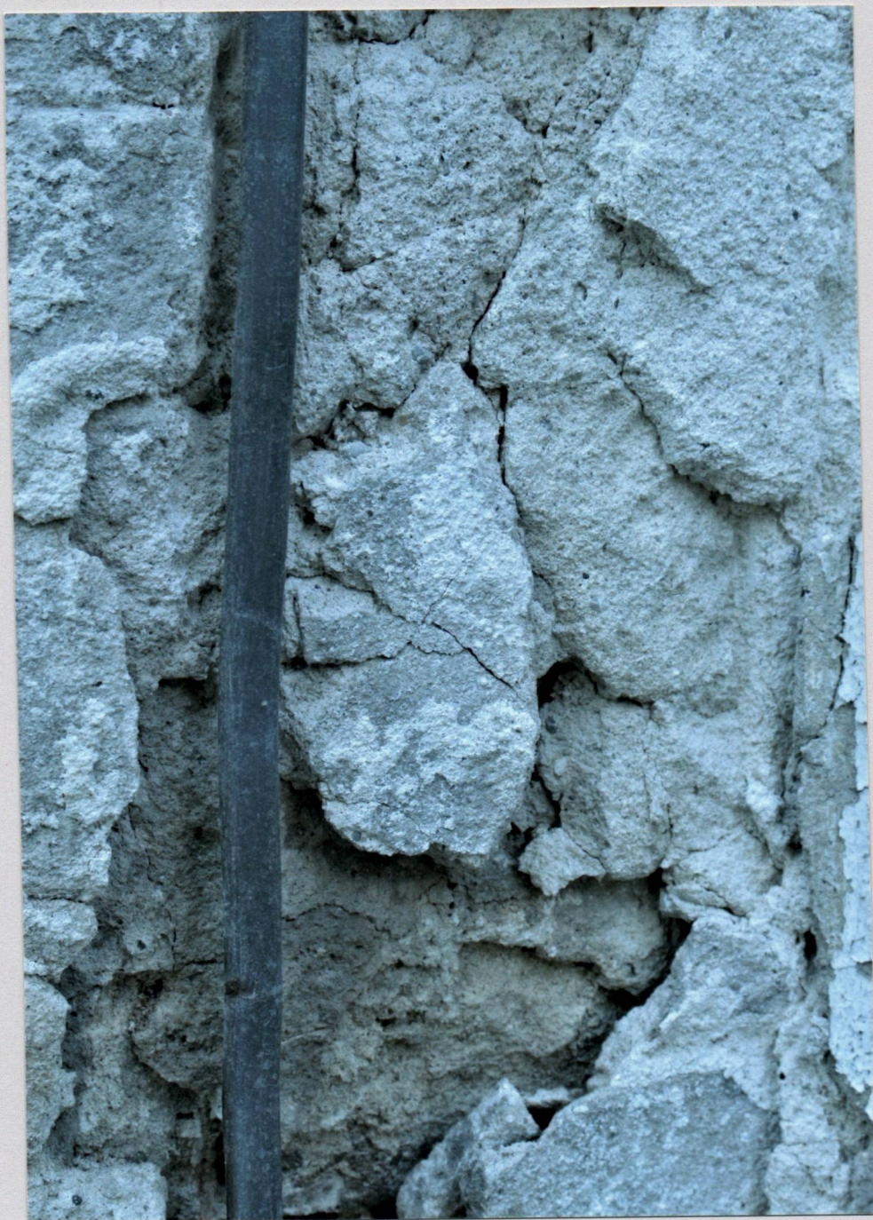
Fot. 35 – Rudółtowice, pałac Zborowskich. Portal na elewacji południowo – zachodniej pałacu. Odkrywka nr 1 – współczesny przewód elektryczny.
