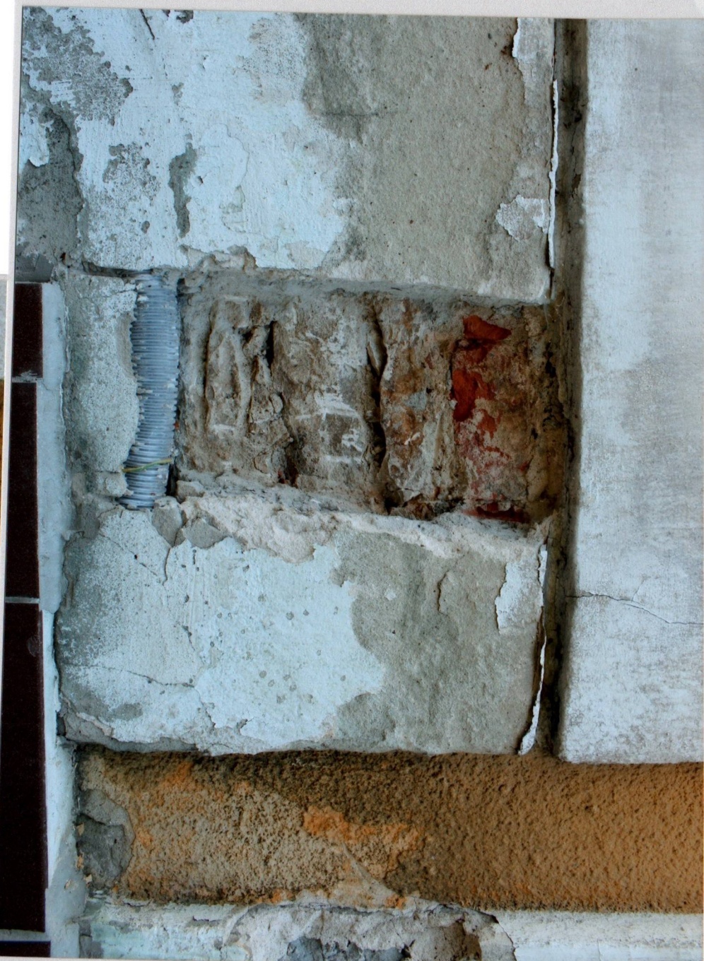
Fot. 43 – Rudółtowice, pałac Zborowskich. Elewacja od strony północno – zachodniej. Odkrywka nr 1. Widoczne uszkodzenia struktury muru i tynków spowodowane montażem współczesnych instalacji z zastosowaniem m.in. silnych zapraw cementowych.
