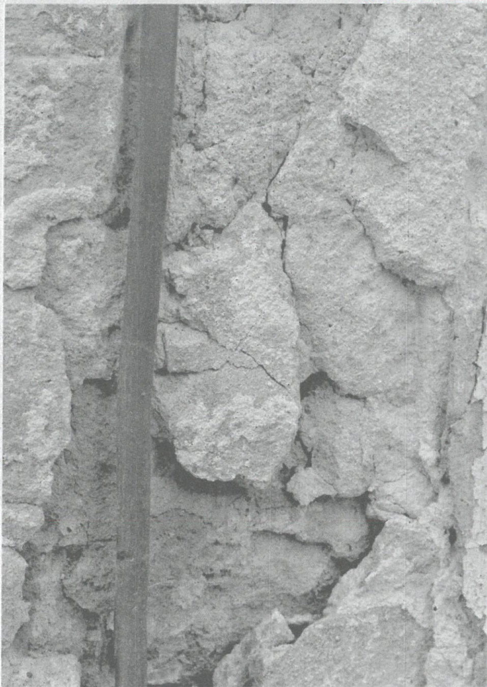
Fot. 35 – Rudółtowiec, pałac Zborowskich. Portal na elewacji południowo – zachodniej pałacu. Odkrywka nr 1 – współczesny przewód elektryczny.
