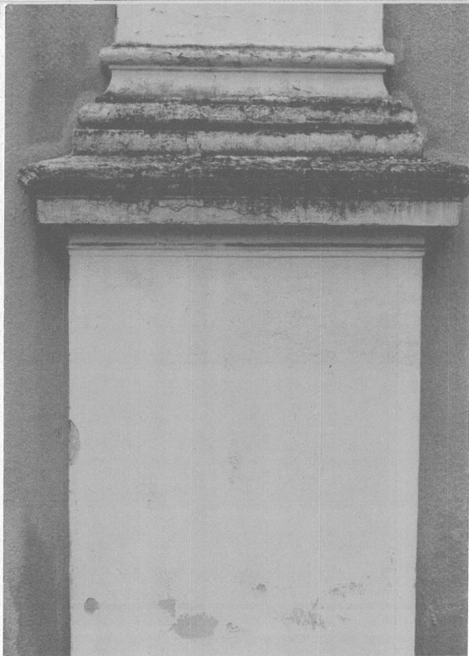
Fot. 29 – Rudołtówice, pałac Zborowskich. Widok na elewację południowo – zachodnią pałacu. Stan zachowania zwieńczenia portalu oraz bazy pilastra po stronie lewej ryzalitu. fot. Jan Gałaszek, maj 2018 r.
